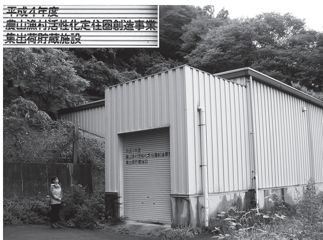
写真5 近代的倉庫造りの集出荷貯蔵施設の風穴(長野県長和町)
