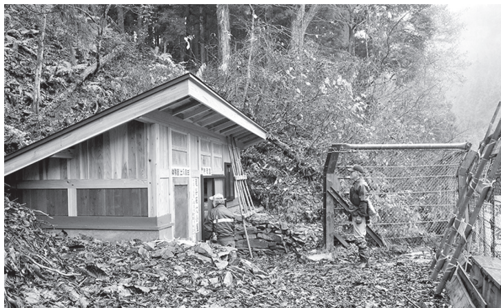
写真4 復元された滝谷風穴の風穴小屋(福島県三島町)
