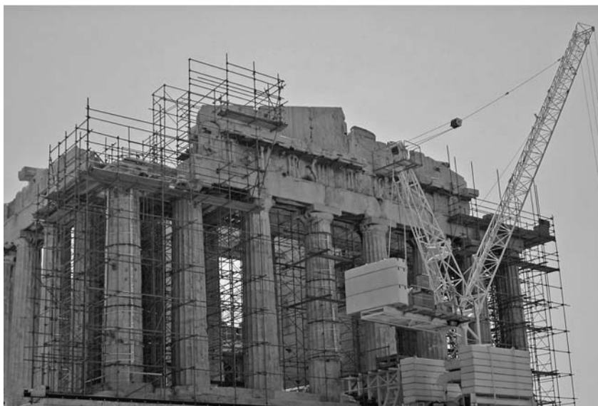
図2：耐震工事中のパルテノン神殿
