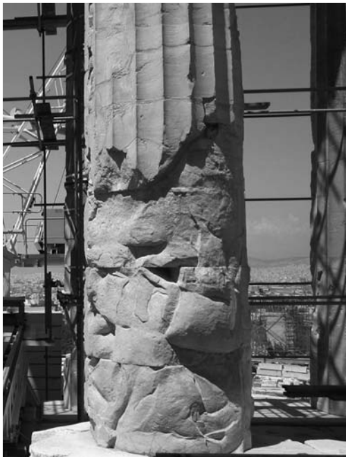
図1：大火災の熱で表面が溶融している石柱
