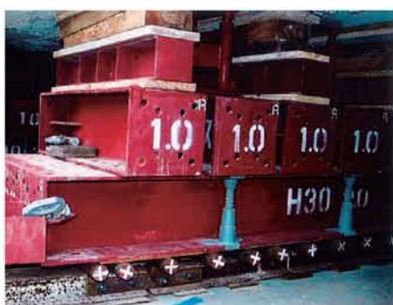
写真2 曳家工法の転動装置 旧JR奈良駅舎本屋の曳家における転動装置。転動装置に建物基礎が載った状態。レール上のコロは直径約8cm。筆者撮影（2004年5月）。
