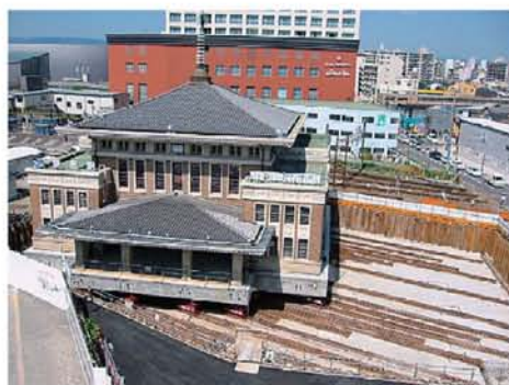
写真4 旧JR奈良駅舎本屋の曳家工事 曳家対象となった駅舎本屋は幅約25m・奥行約24m、重量約3,500tである。踏切すいすい大作戦ホームページ ( http://www.renritsukyo.com/ ) から引用。
