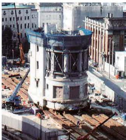
写真1 曳家工事の実施例 横浜銀行本店社屋の曳家事例。この建物で重量1,315t、約170mの大掛かりな曳家が行われている。間瀬建設工法誌「建物の移動」から引用。
