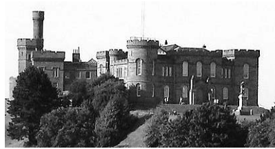
（1746年に破壊され1836年に再建されたインヴァネス城）
